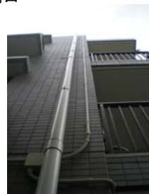
配管工事の様子
