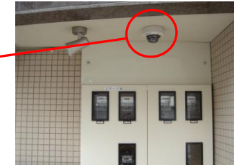
ゴミ置き場 全天候型ドームカメラ
