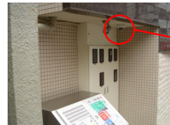
ゴミ置き場 全天候型ドームカメラ
