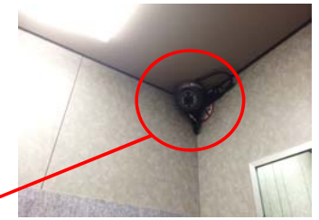
エレベーター内
