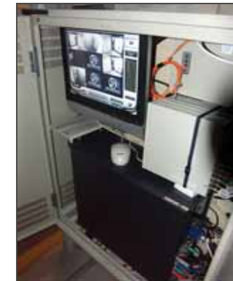
録画装置ラック内部
