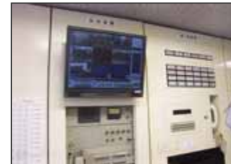
管理室モニター設備
