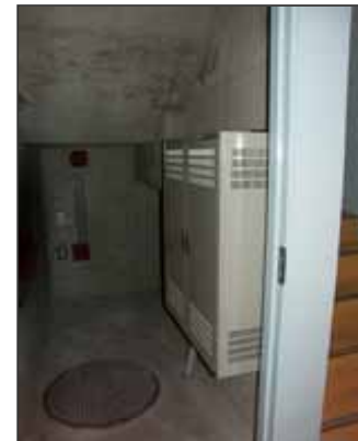
機械室内録画装置収容ラック
