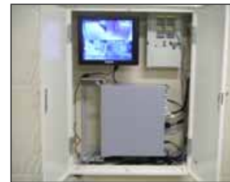
各ホーム配置録画装置ラック
