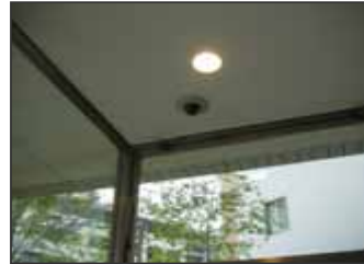
エントランス天井埋め込みカメラ
