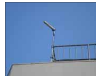
各棟無線LANアンテナ設備
