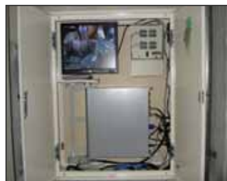
各棟録画装置設備ラック内部
