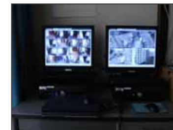
管理事務室モニター
